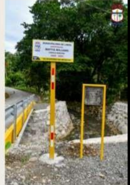
Reparación Puente la Colonia
