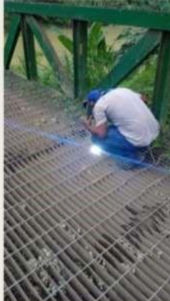
Reparación Puente la Guaria
